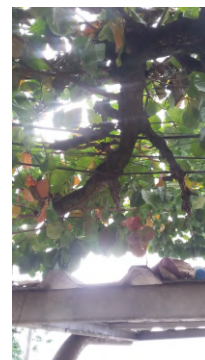
Figura 5: Interferência dos galhos na rede elétrica
